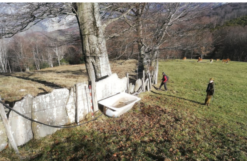
5 / El insólito cierre de la finca de Yanos de Braña, con el llamativo alineamiento de lastras de grandes dimensiones, sustancia una modalidad ajena a la de los muros de mampuesto dominantes en la zona, particularmente en parajes de tan elevada altitud.
